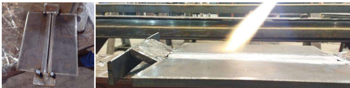
Figura 4 – Pré-aquecimento e soldagem da chapa-teste destinada ao TCC
